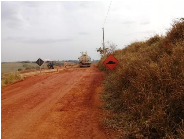
Foto 77 – Sinalização interna – redutor de velocidade. (Data: 15/08/2020)
