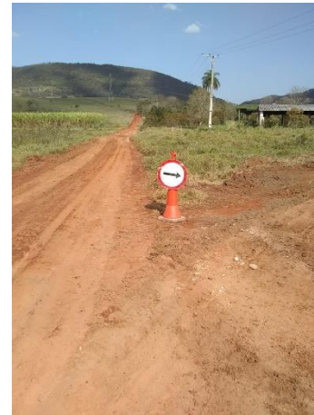
Foto 78 – Sinalização interna de indicação de mão. (Data: 19/08/2020)
