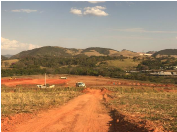
Foto 106 – Bota Espera Margem Direita (Data: 14/08/2020)
