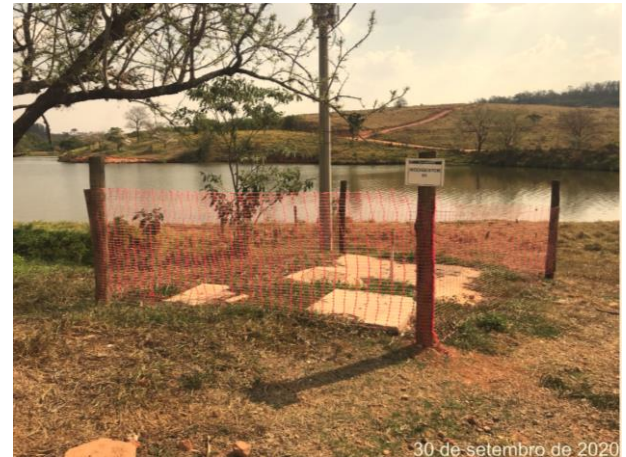
Foto 94 – Biodigestor implantado no canteiro administrativo (Data: 30/09/2020)
