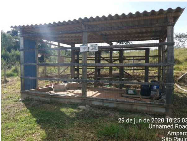
Foto 15 – Baía de armazenamento de cimento (Data: 29/06/20)
