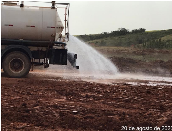
Foto 97 – Umectação de via externa. (Data: 20/08/20)
