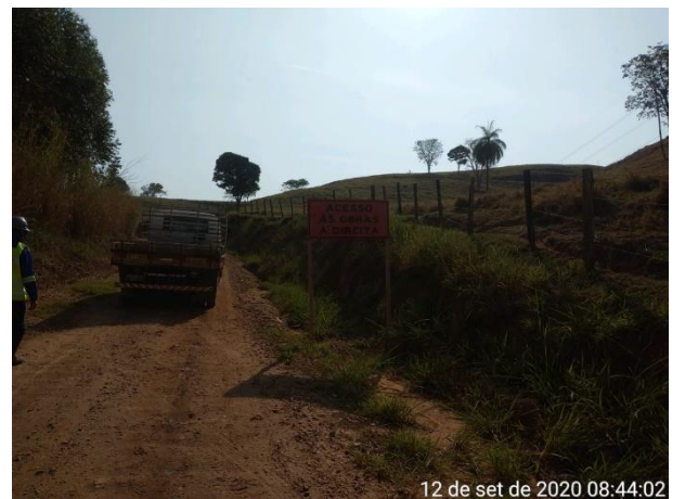
Foto 72 – Sinalização de obra. (Data: 12/09/2020)
