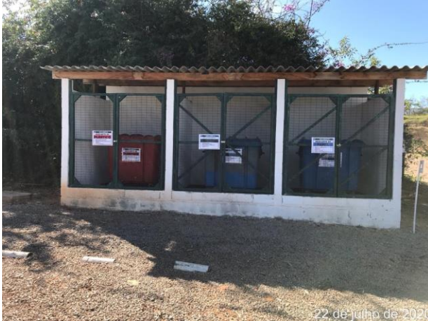
Foto 100 – Baía de resíduos recicláveis no canteiro. (Data: 22/07/20)
