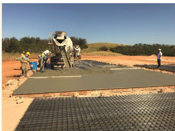
Foto 91 – Implantação do canteiro industrial com utilização de concreto. (Data: 23/09/20)
