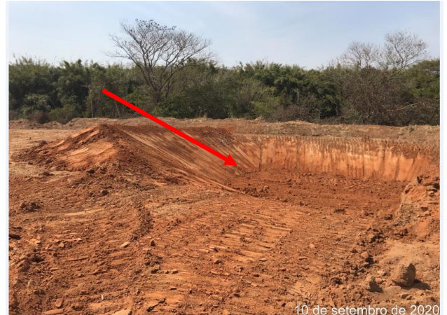
Foto 86 – Canaletas e cacimba para direcionamento da água pluvial recebimento de sedimento (Data: 10/09/2020)
