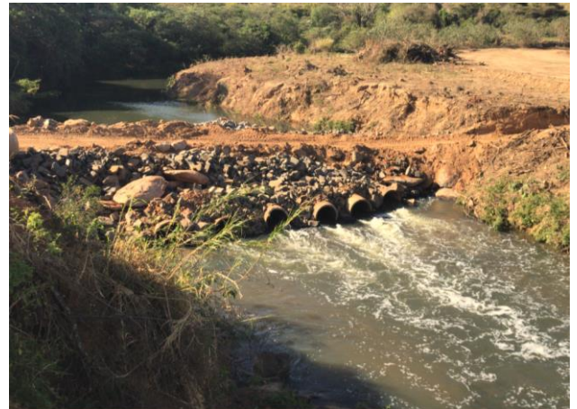
Foto 111 – Passagem molhada finalizada sobre o rio Camanducaia (Data:02/09/2020)
