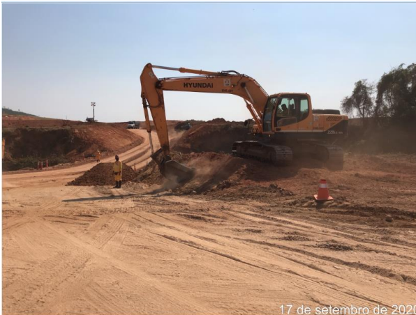
Foto 87 – Equipamento realizando reconformação do talude. (Data: 17/09/2020)
