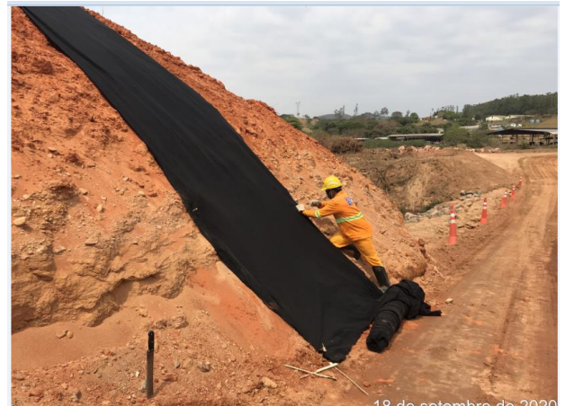
Foto 88 – Manta geotêxtil para proteção de talude. (Data: 25/09/2020)
