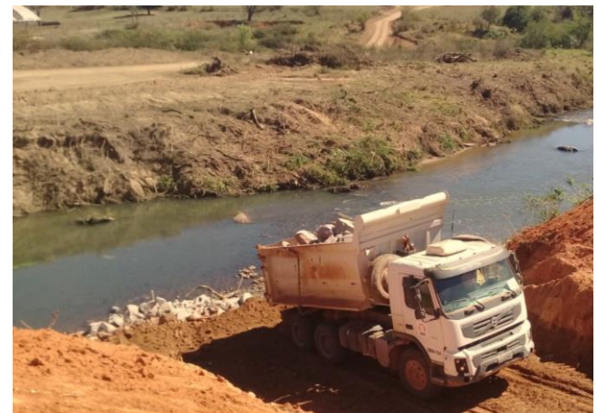
Foto 109 – Movimentação de material para implantação da Passagem molhada sobre o rio Camanducaia (Data: 26/08/2020)
