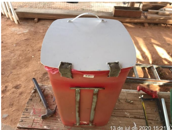
Foto 37 – Adequação de coletor seletivo com inclusão de tampa. (Data: 13/07/20)
