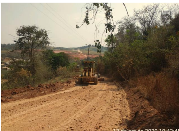
Foto 114 – Abertura de acesso e disciplinamento da água. (Data: 12/09/2020)
