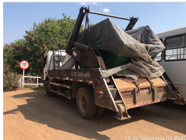
Foto 104 – Retirada de resíduo comum do canteiro por empresa contratada. (Data: 15/09/20)
