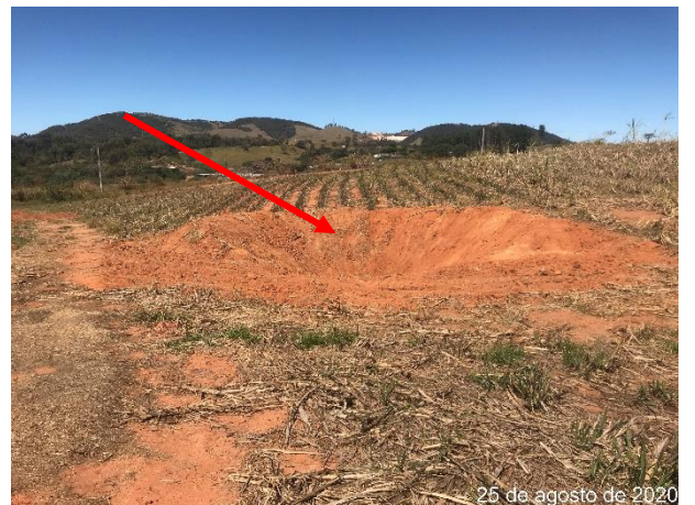
Foto 84 – Cacimba para retenção de sedimentos. (Data: 25/08/2020)
