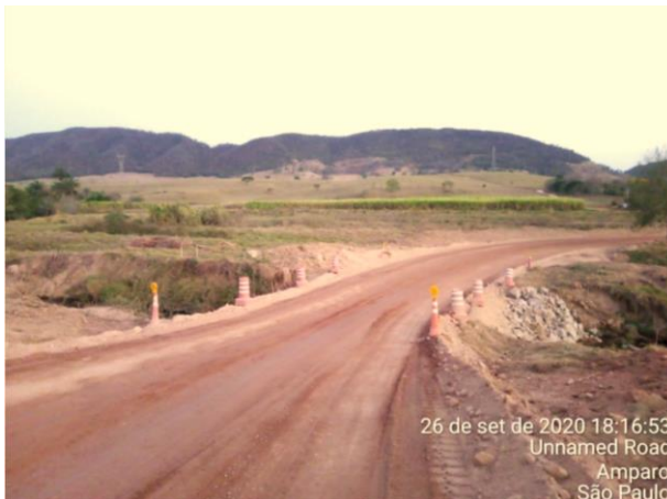
Foto 112 – Passagem molhada sobre o Córrego Pantaleão finalizada (Data: 26/09/2020)
