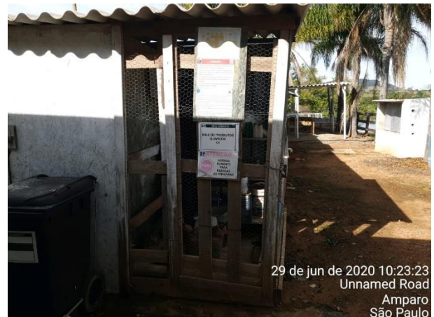
Foto 16 – Baía de produtos químicos canteiro administrativo (Data: 28/06/20)
