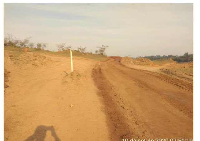
Foto 115 – Movimentação de solo para abertura de acesso interno. (Data:10/09/2020)
