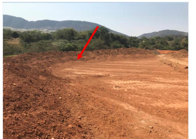
Foto 90 – Área do Bota Espera com disciplinamento de água e barreira para proteção. (Data: 25/09/20)
