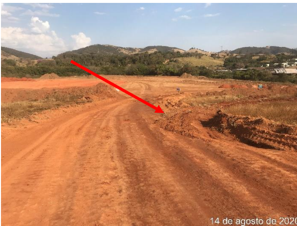
Foto 81 – Disciplinamento da água sentido vegetação rasteira e canaletas. (Data: 14/08/2020)
