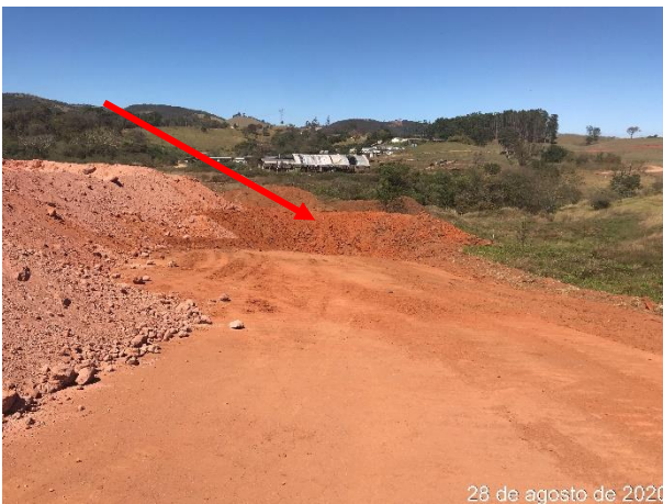
Foto 83 – Cacimba para retenção de sedimentos. (Data: 28/08/2020)
