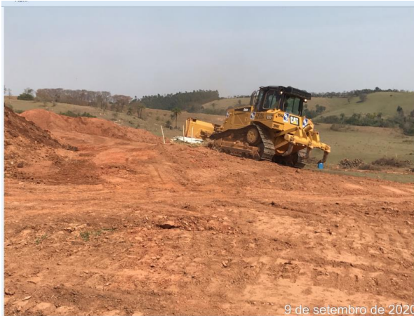
Foto 85 – Máquina (Patrol) realizando Disciplinamento da água sentido vegetação rasteira e canaletas. (Data: 09/09/2020)
