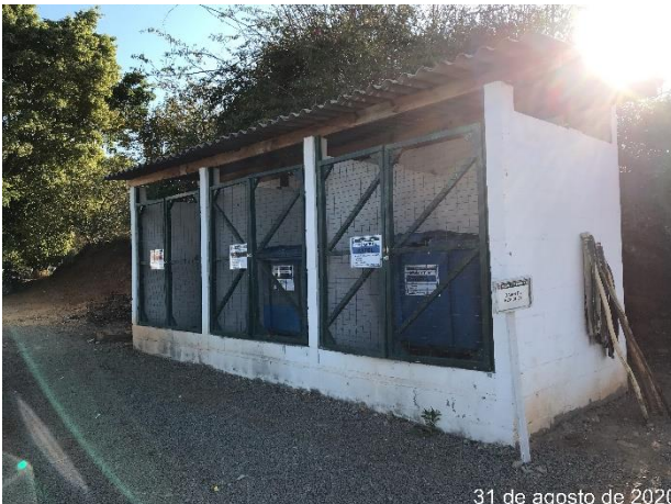
Foto 102 – Baía de resíduos recicláveis no canteiro. (Data: 31/08/20)
