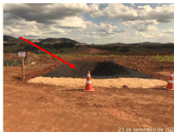
Foto 92 – Local para lavagem de bica das betoneiras. (Data: 23/09/20)
