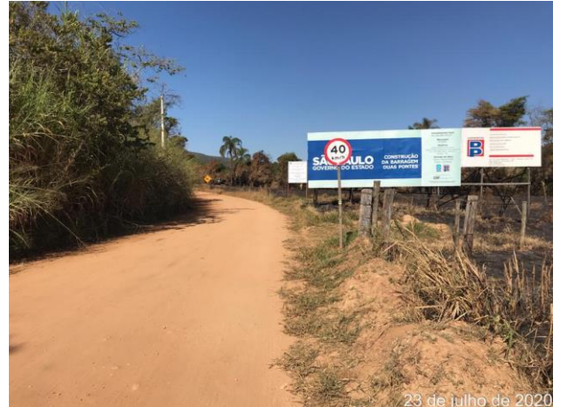
Foto 68 – Sinalização de obra. (Data: 23/07/2020)
