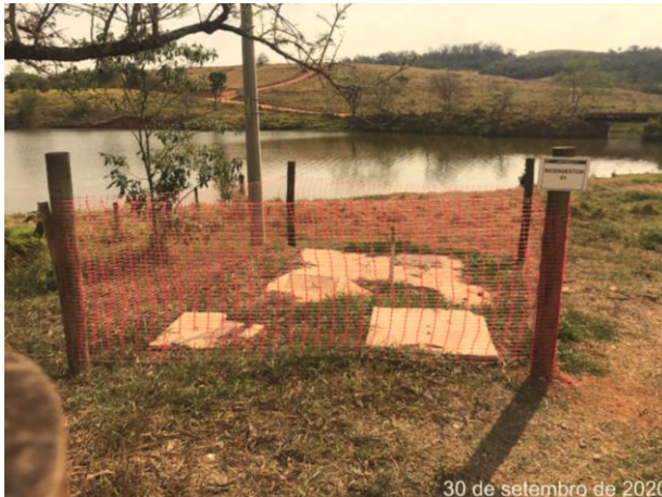
Foto 93 – Biodigestor implantado no canteiro administrativo (Data: 30/09/2020)
