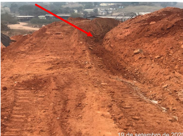
Foto 89 – Canaleta provisória para direcionamento da água pluvial. (Data: 19/09/20)
