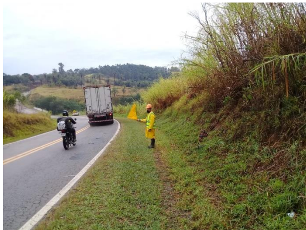
Foto 69 – Colaborador sinalizando atividade proxima e redução de velocidade. (Data:22/08/20)
