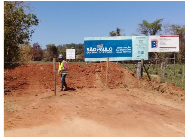
Foto 80 – Sinalização e cercamento da obra. (Data: 04/09/2020)
