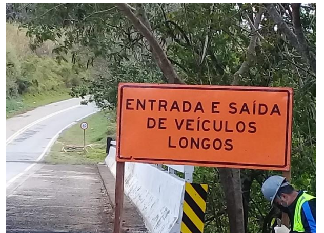
Foto 70 – Sinalização de obra. (Data: 22/08/2020)
